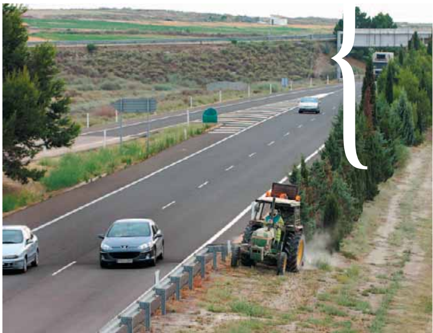
Trabajos de desbroce de taludes de acesa .
